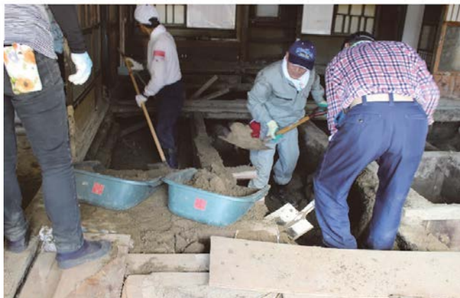
床下の土砂を運んでいる様子
